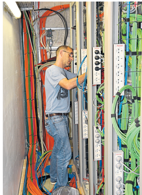
Le câblage a été entièrement mis à jour.
