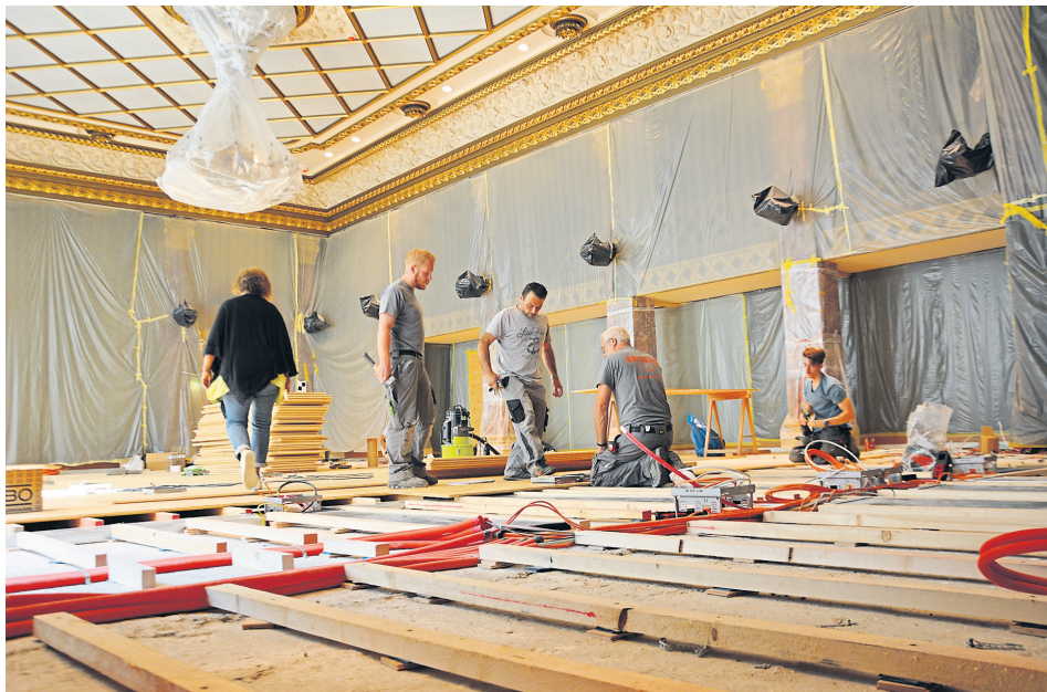
Le sol de la salle plénière, élément majeur du chantier
